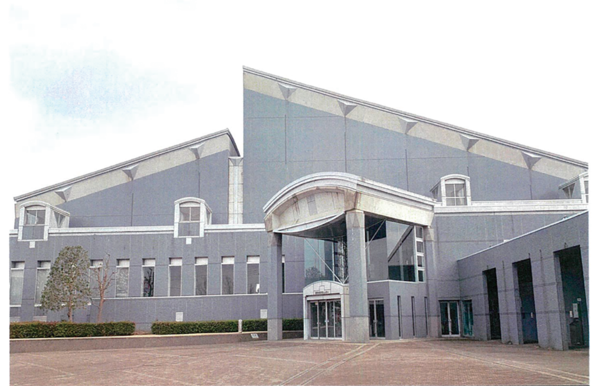
結城市民文化センターアクロス特定天井等改修工事施工
