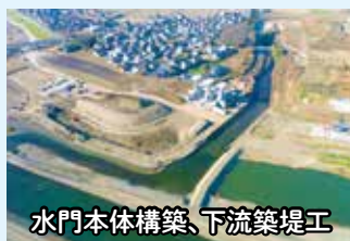
田川河道切替、上下流築堤工
