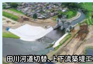
水門本体構築、下流築堤工
