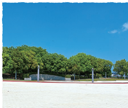
遮熱素材で舗装された噴水広場
