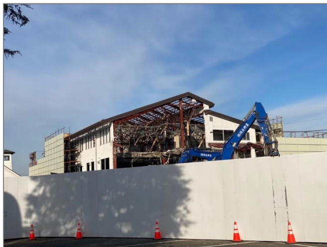
解体される元市役所本庁舎
