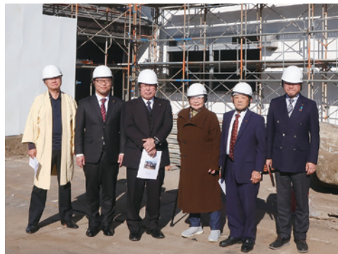
元市役所本庁舎 調査事項：元市役所本庁舎解体工事について
