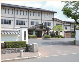
西の宮にある旧庁舎
