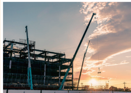
「新結城市役所建築中」 (令和元年11月)
