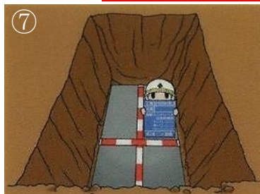
⑦ 基礎コンクリート 出来形検測 L = △△△ W = △△△ H = △△△
