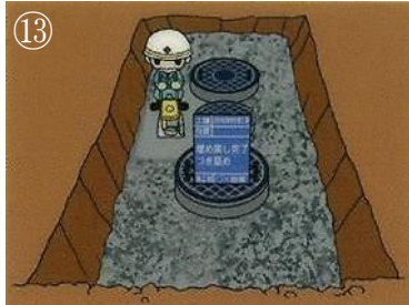
⑬ 埋め戻し完了、つき固め
