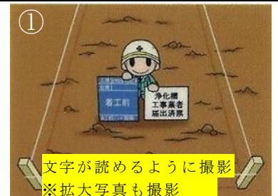
① 着工前 浄化槽設備士監督 ※背景に工事を行う場所の周辺状況
