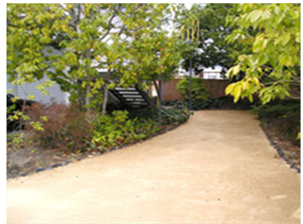
図5-38 園路舗装の事例（土系舗装）
