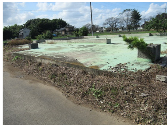
図5-6 倉庫の土間と基礎
