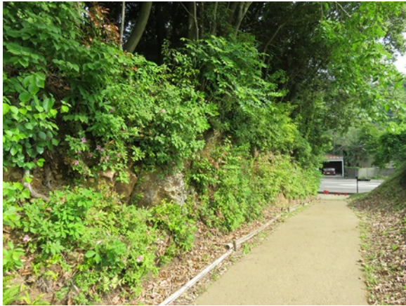
図5-36 園路舗装の事例（脱色アスファルト舗装）
