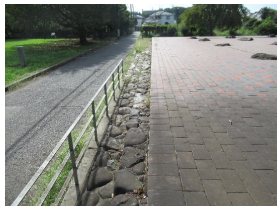
図5-34 道路に接する部分の段差処理 （東京都国分寺市 武蔵国分寺跡）
