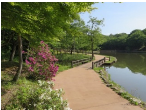
図5-37 園路舗装の事例 （透水性高炉スラグ舗装）
