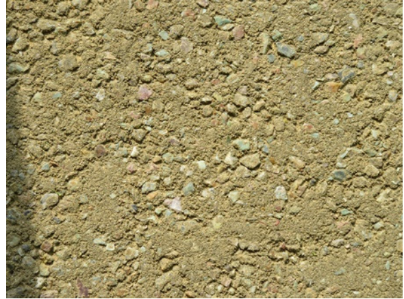
図5-36 園路舗装の事例（脱色アスファルト舗装）
