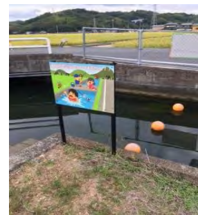
注意看板と脱出ロープ
