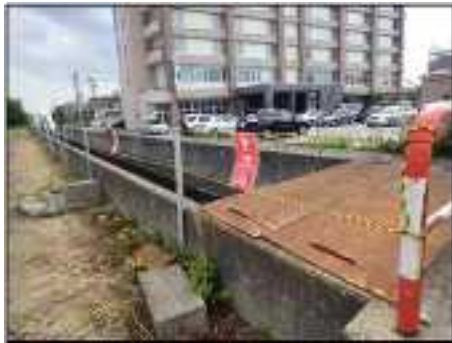
応急ロープの設置
