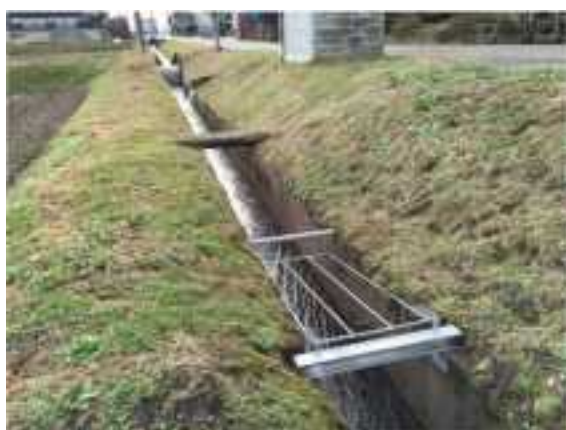
救助用スクリーンの設置
