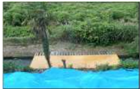
水路への仮蓋の設置
