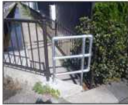
侵入防止柵を設置 (新潟県新潟市)
