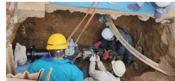
老朽化した水道管を交換する様子
