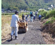
未舗装農道の舗装
