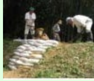
漏水箇所の補修
