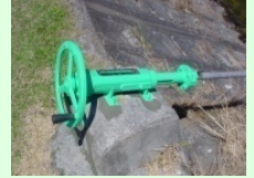
ゲート、バルブの更新
