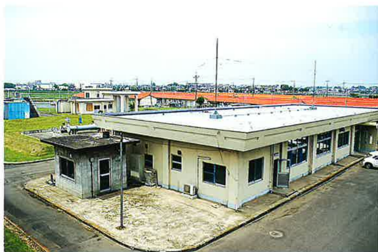
▲林浄水場(昭和49年完成)
