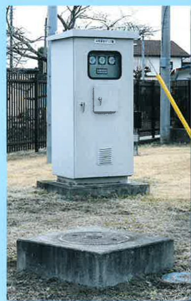
▲深さ約200mの深井戸から水中ポンプで水を汲み上げます。
