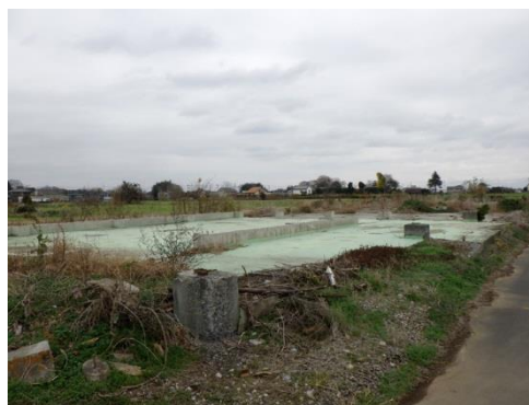
⑥ 史跡内残留物 (建物基礎(4))
