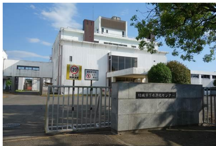
結城市下水浄化センター
