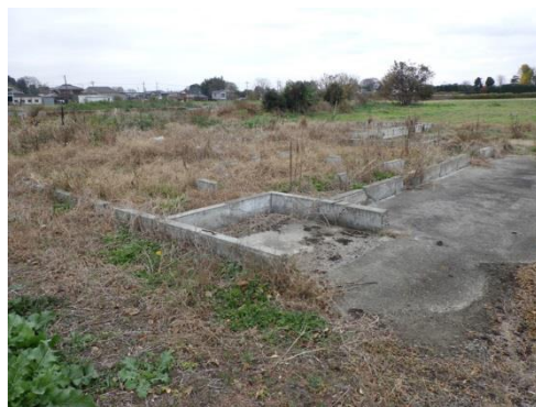
④ 史跡内残留物 (建物基礎(2))
