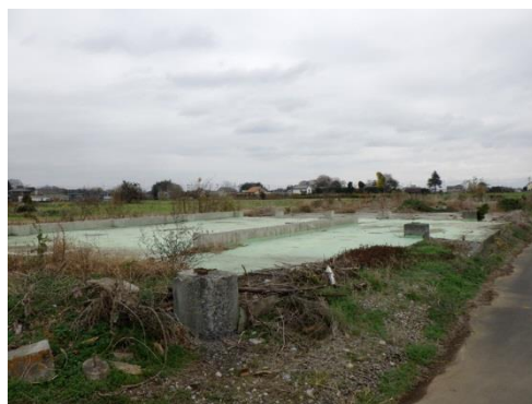
⑥ 史跡内残留物 (建物基礎(4))
