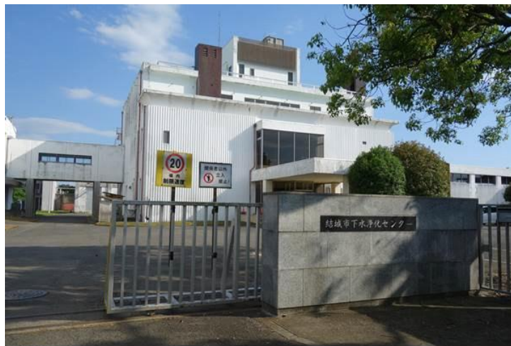
結城市下水浄化センター
