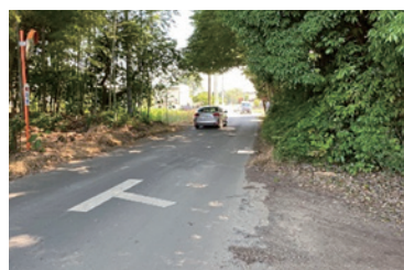
▲南部中央幹線道路未整備区間
