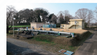
約55年が経過した本町浄水場
