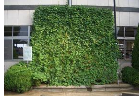
▲ 市役所第2庁舎のグリーンカーテン
