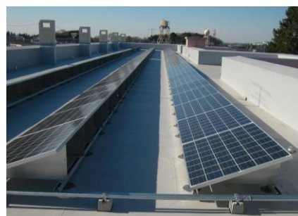
▲ 太陽光発電システム(結城小学校)
