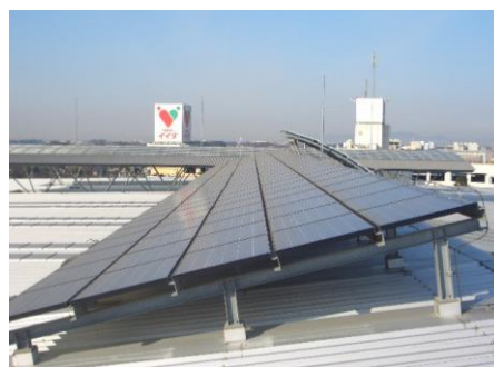
▲ 太陽光発電システム(情報センター)
