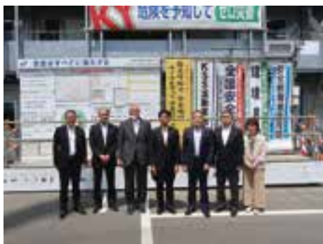
▲新庁舎建設工事現場
