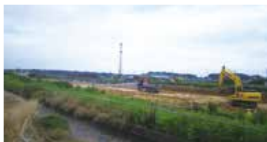
▲上山川北部地区工業団地造成工事
