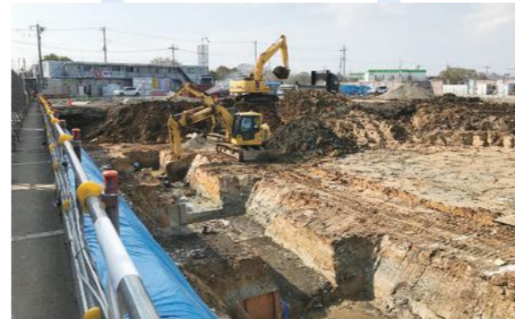
② 掘削・基礎工事(掘削)
