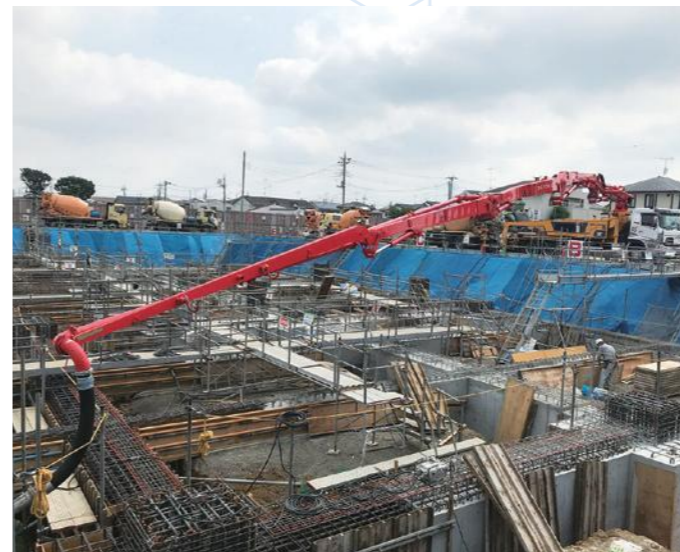
④ 掘削・基礎工事(基礎コンクリート打ち)
