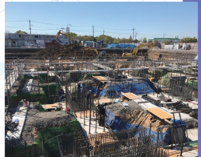
③ 掘削・基礎工事(鉄筋組み立て)
