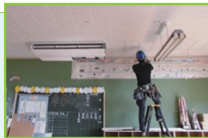
小中学校教室へのエアコン設置工事が始まりました。
