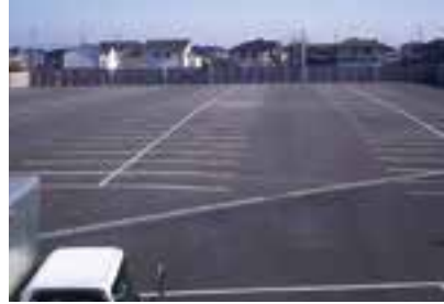
▲新庁舎建設工事現場
