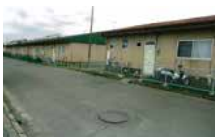
▲かなくぼ市営住宅
