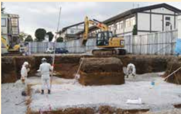
▲公民館建設予定地
