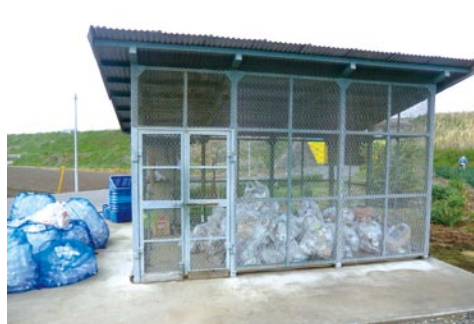
▲補助事業により整備された集積所
