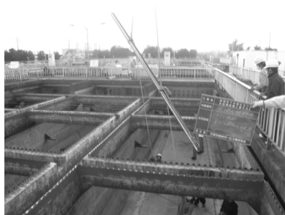
□ 下水浄化センター改築事業
