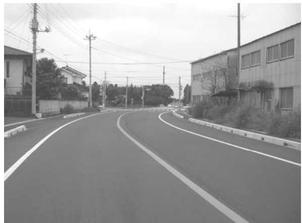
□ 整備された松木合地内の道路
