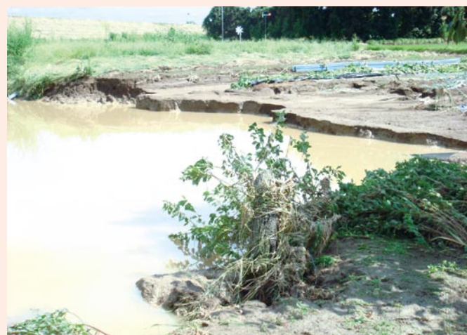
浸水によりえぐられた農地(山王)
