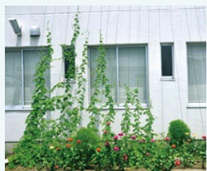
市立公民館北部分館
