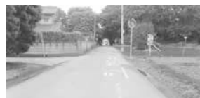
▲南部中央幹線道路未整備区間
