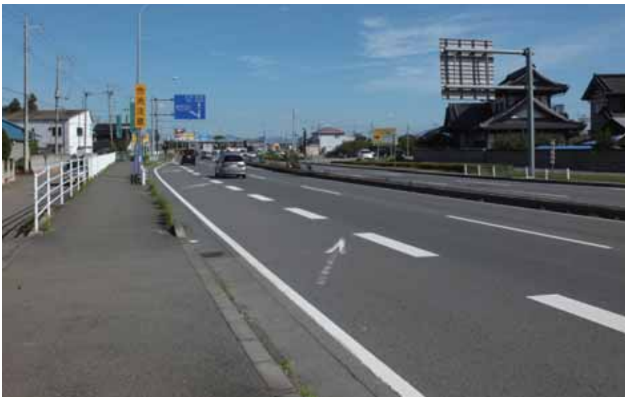
▲道路軸（国道50号バイパス）
