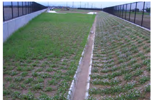
▲敷地内の空地や法面、擁壁などの緑化や除草などの維持管理に努めましょう。
