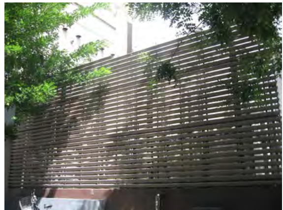
▲通りに面した建築設備をルーバーで覆い隠した例（茶系の色彩も周辺の景観への配慮が感じられます。）
