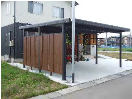
▲和風デザインで地域の景観に調和する工作物（屋根付駐車場）の例
