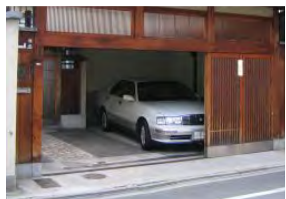
▲道路に面する駐車場の見え方に配慮し、伝統的な格子デザインを取り入れた例
