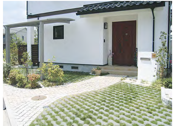
▲道路に面して設置していますが、開放的な配置や駐車面の緑化などに配慮した例
