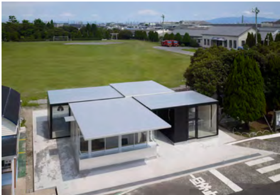
▲シンプルな門構えデザインで景観に配慮した工場エントランスの例
