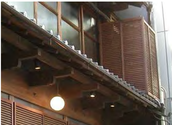
▲格子で覆い隠し、通りから室外機を目立たないように配慮した例
