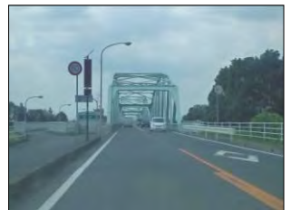
20. 県道結城下妻線 (栄橋)
