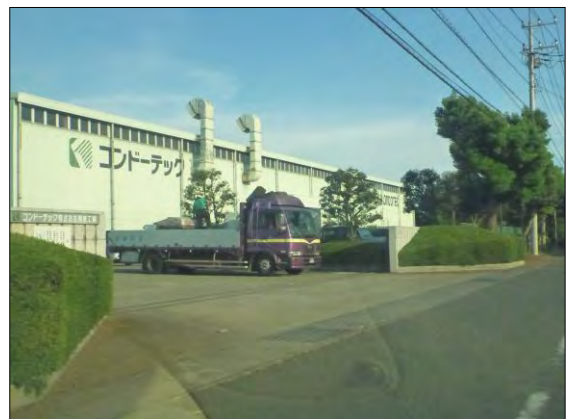
■ 景観に配慮された工業地（結城第一工業団地）
