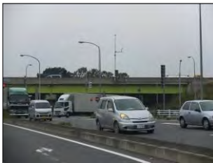
13. 50号バイパス（新4号東手前）
