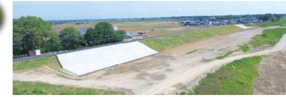
決壊箇所の堤防復旧工事完成(上三坂地区:平成28年6月10日撮影)
