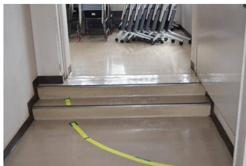
【庁舎内の段差】
