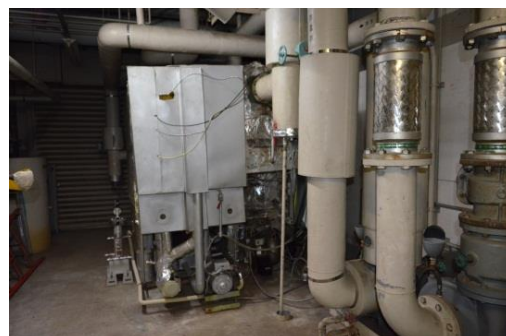
【老朽化したボイラー】
