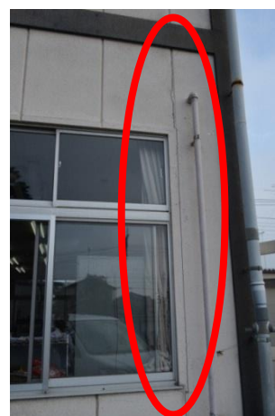
【壁面の亀裂】
