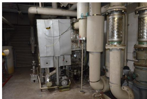
【老朽化したボイラー】
