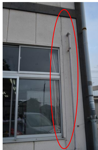
【壁面の亀裂】
