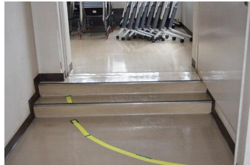
【庁舎内の段差】
